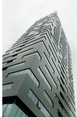
Slimcase est un concept appliqué à un système de fenêtre de vue minimaliste, dominé par le verre et apparaît vers l'extérieur d'avoir un collage structural. L'extérieur dispose d'un cadre au vitrage de bordure noir sérigraphiée, défini par une fine expression de l'aluminium.
